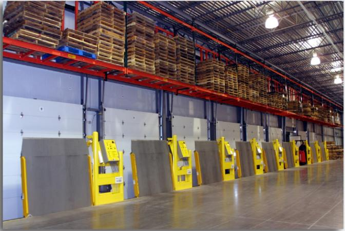
El nivelador serie VS de Poweramp se almacena en posición vertical, lo que permite que la cortina metálica no se dañe. Se puede incluir el almacenamiento en estante de cortina metálica para maximizar el almacenamiento de paletas vacías.
