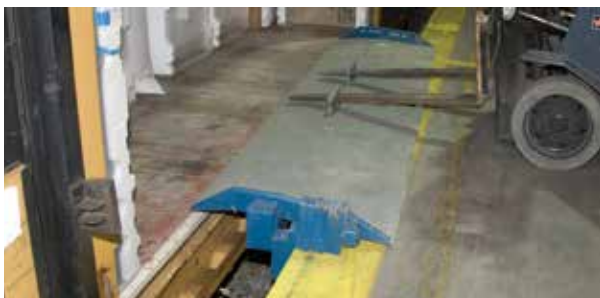
Colocación de Placa de Ferrocarril
